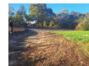
Nous permettant l'alimentation de la zone décaissée qui deviendra une zone humide à Chitenay
